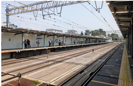
（西武線の某駅舎）
