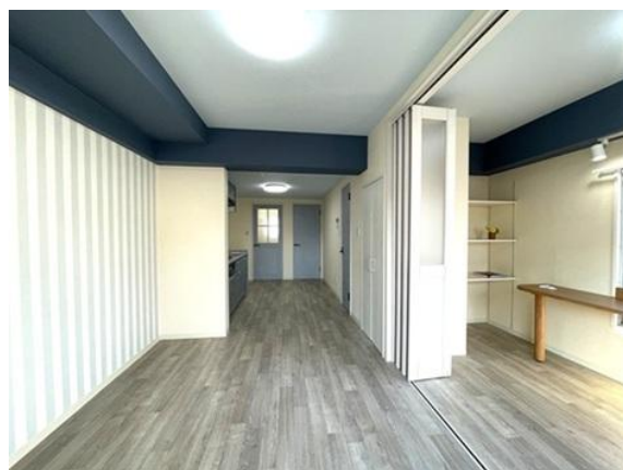
施工事例—キッチン・和室2間をLDKと折れ戸で仕切るワークスペースに間取り変更
